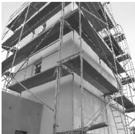
Prace remontowe OSP i świetlicy w Turznie
