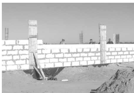
Stacja uzdatniania wody w Świerczynach
