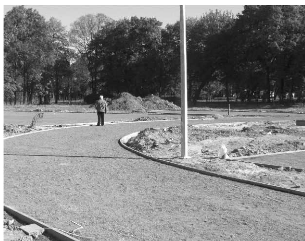
Prace przy budowie ORLIKA w Turznie
