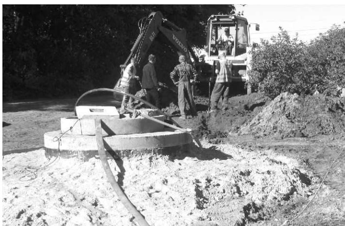
Budowa kanalizacji na Folsagu
