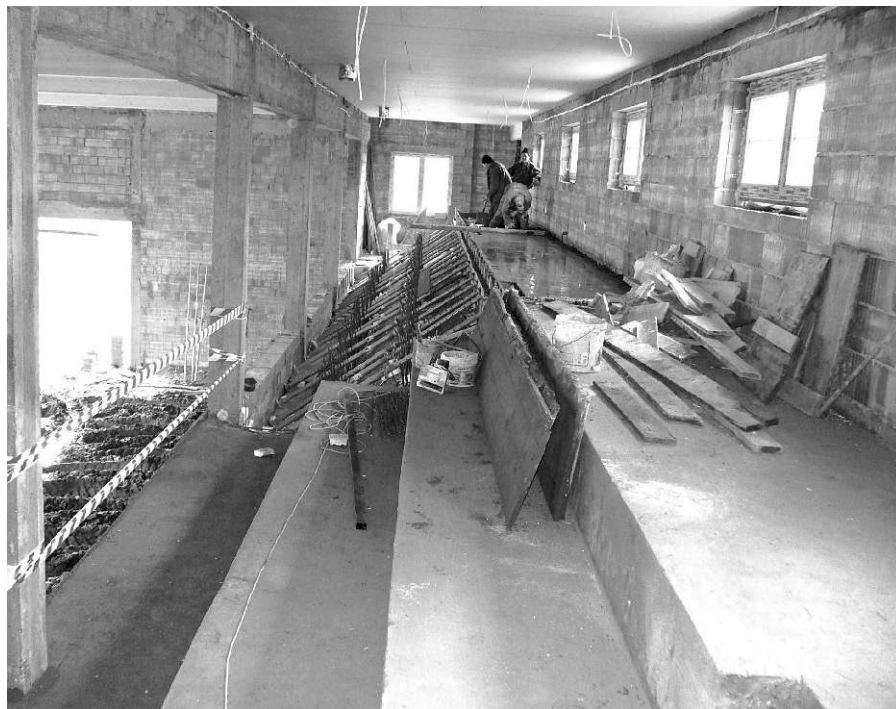
Budowa trybun na hali sportowej w Turznie
