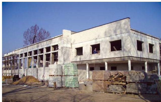
Budowa hali sportowej w Łysomicach
